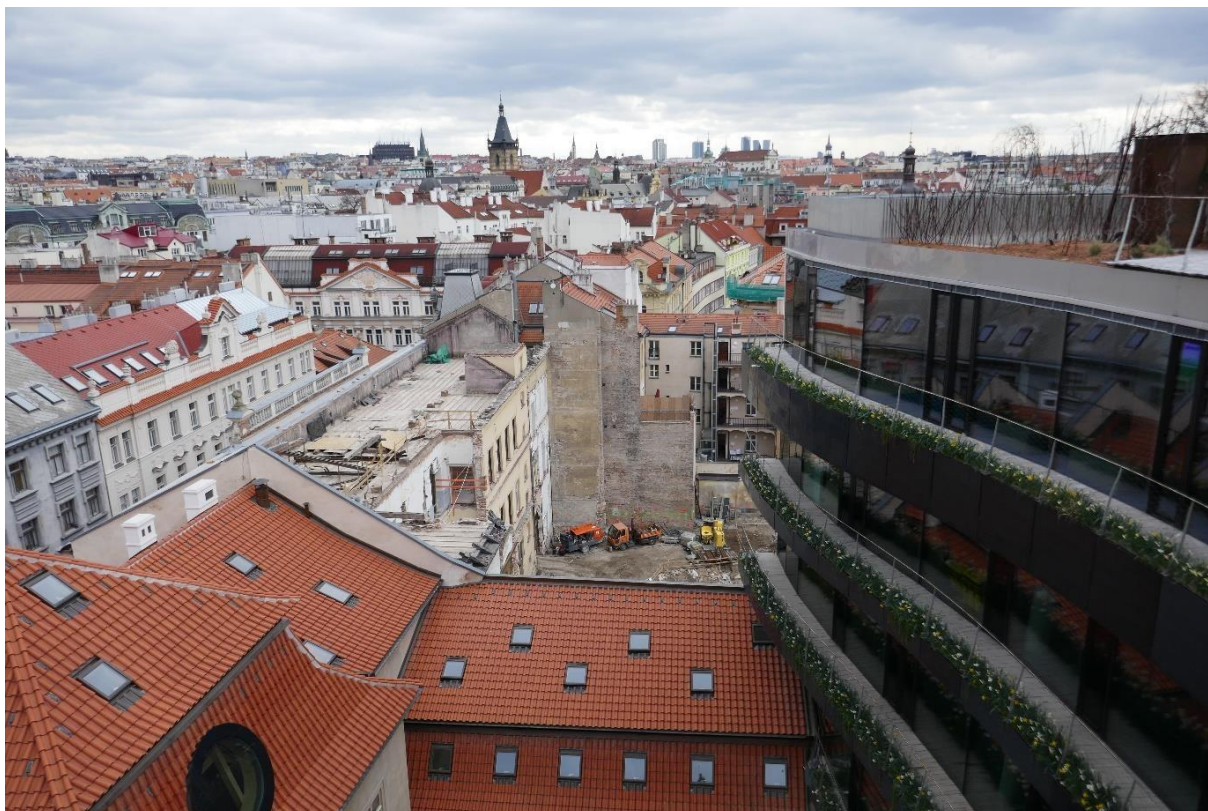
Obr. 28 Staré a nové z pohledu jihovýchodně ze střechy nové budovy.
