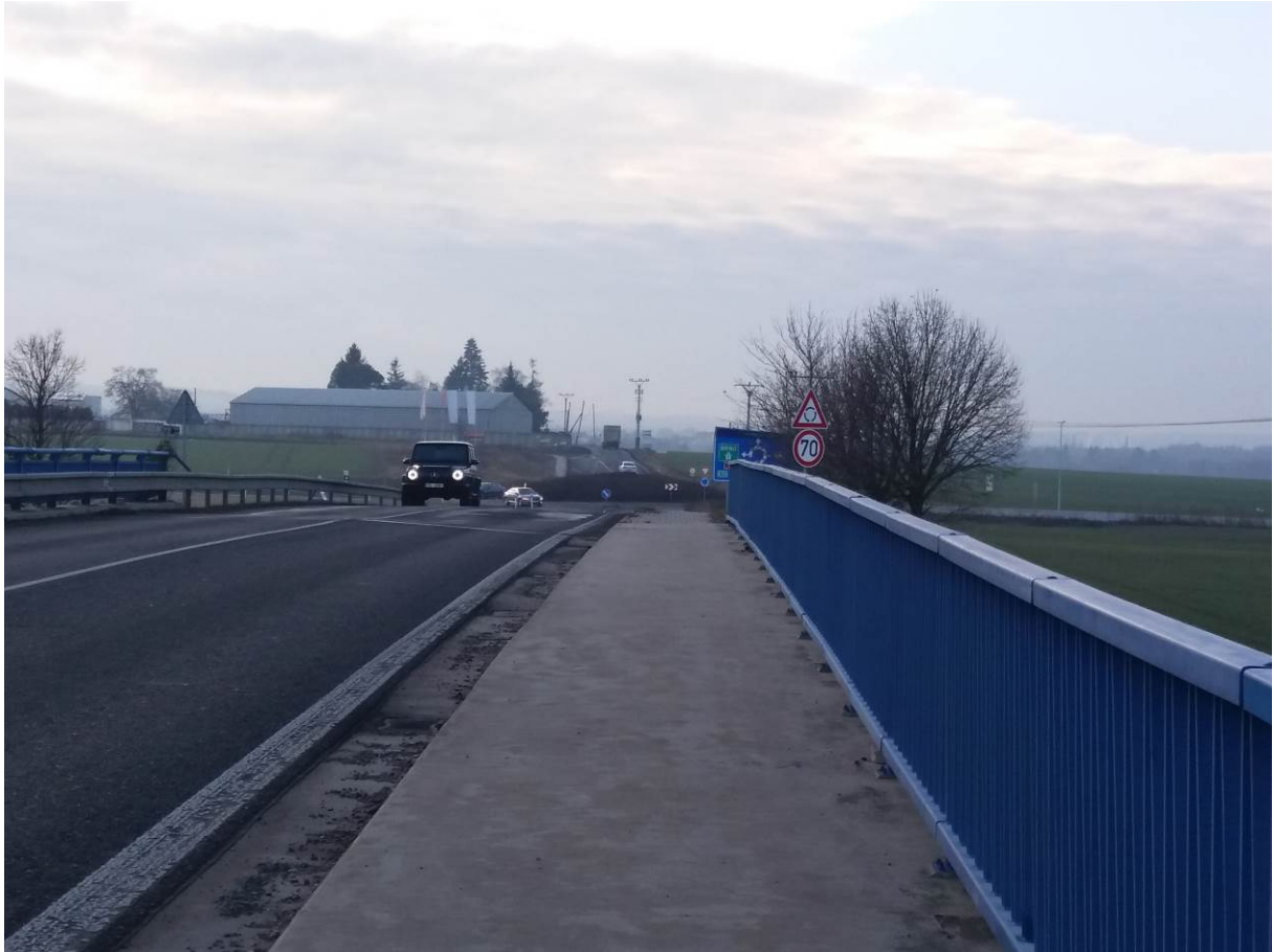
pohled z přejezdu K8 nad D1 směrem k Dobřejovicím
