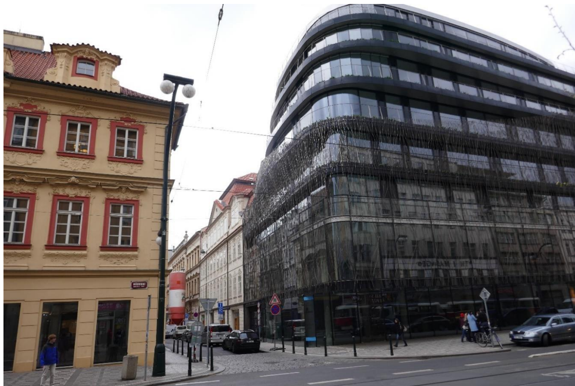
Obr. 26 jihovýchodní pohled z Národní třídy do Mikulandské ulice s novou budovou před barokním palácem a dalším barokním palácem přes Mikulandskou ulici.
