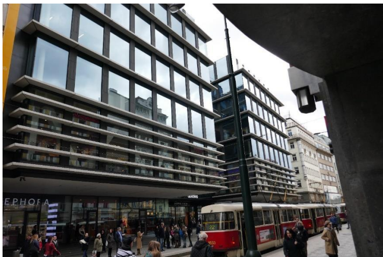
Obr. 23 Budova Quadrio ze severozápadu, směrem do Spálené ulice; obě průčelí jsou propojena obchodní pasáží.
