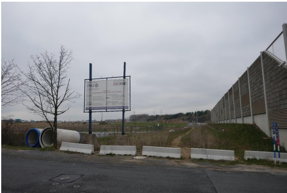
Obr. 52 Pohled jihovýchodně z bodu G na obr. 51 ukazující protihlukovou stěnu postavenou mezi oblastí rozvoje F a obcí.
