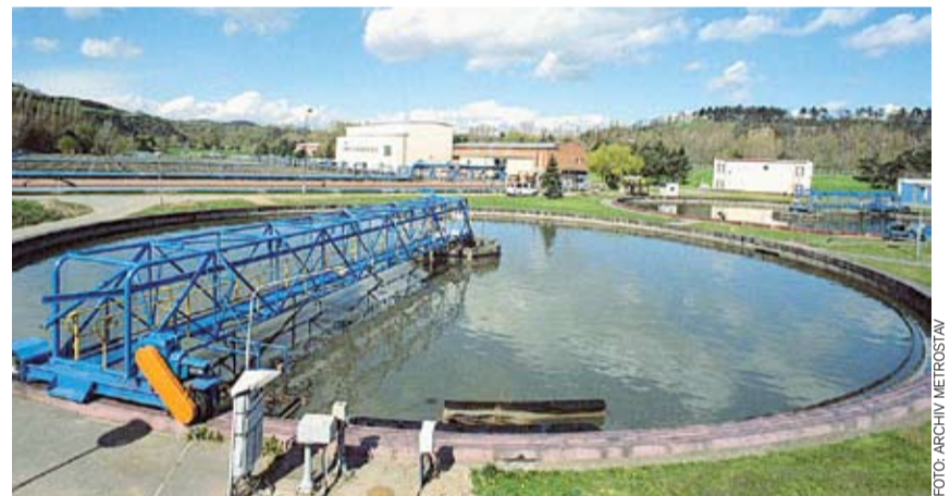
REKONSTRUKCE ústřední čistírny odpadních vod v Troji je jednou z priorit města
