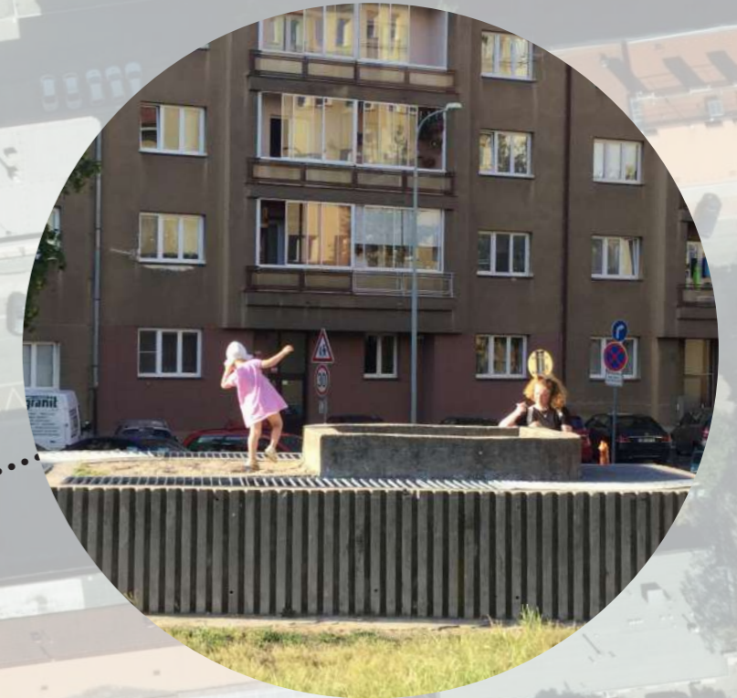
VÝDECHOVÝ OBJEKT KOLEKTORU
