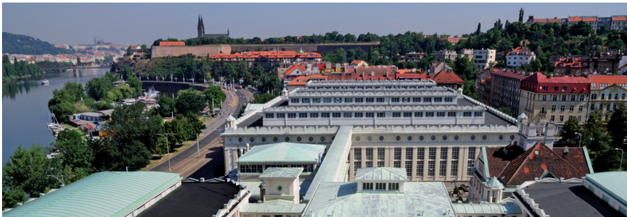
Obr. B2.2.5: Úpravna vody Podolí
