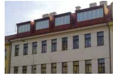
zcela nevhodná velikost vikýřů – PZ
