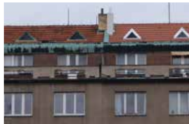
doplnění trojbokých vikýřů vpravo, historické jsou vlevo – vikýře měly být s měděným oplechováním – PZ
