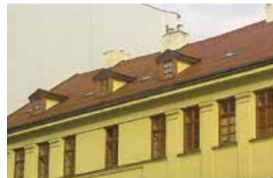
nové sedlové vikýře na domě v PZ
