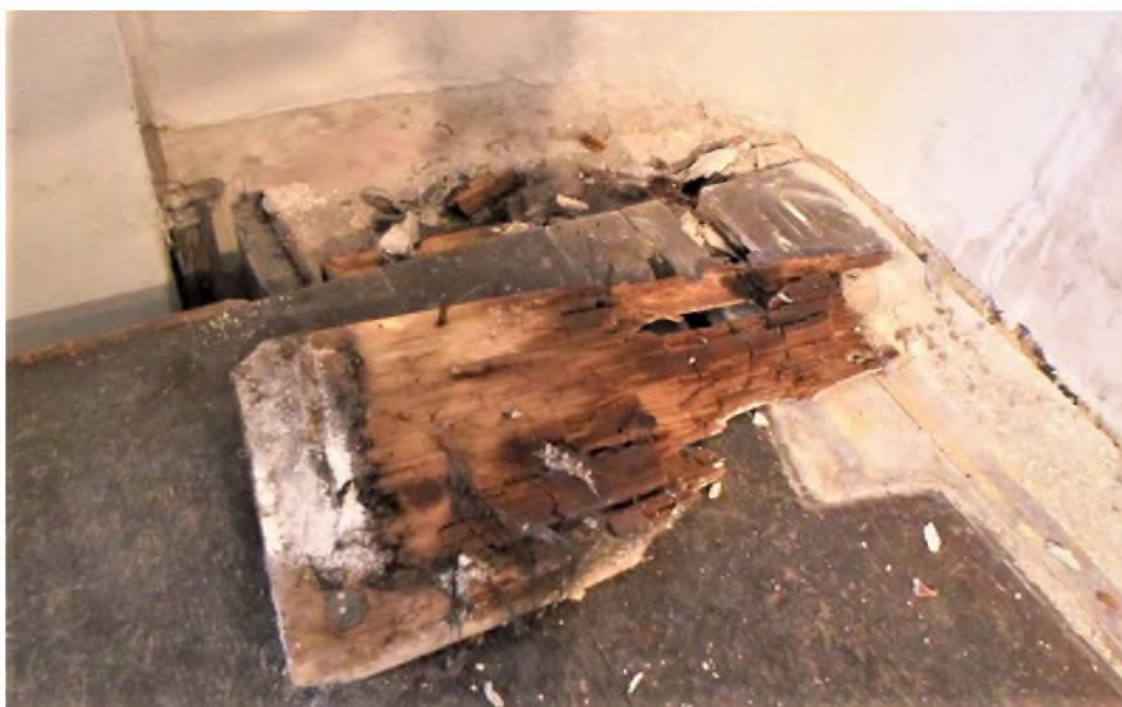
3) Dekomponované dřevo oltáře – detail po demontáži
