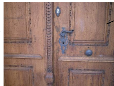
restaurování vstupních vrat
