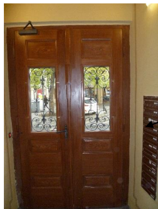
detail restaurování vstupních vrat
