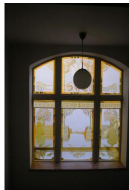
leptaná skla – doplnění původních novými
